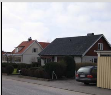
Större delen av bebyggelsen i närområdet utgörs av villor i 1-2 våningar.
