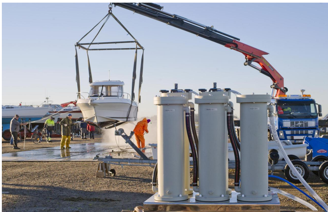
Miljöanpassat båtuftag i Träslövsläges båtsällskap. Högtryckstvättning över spolplatta med grovrensränna samt efterföljande reningssteg med kolfilter. Bild: Lennart Benson
