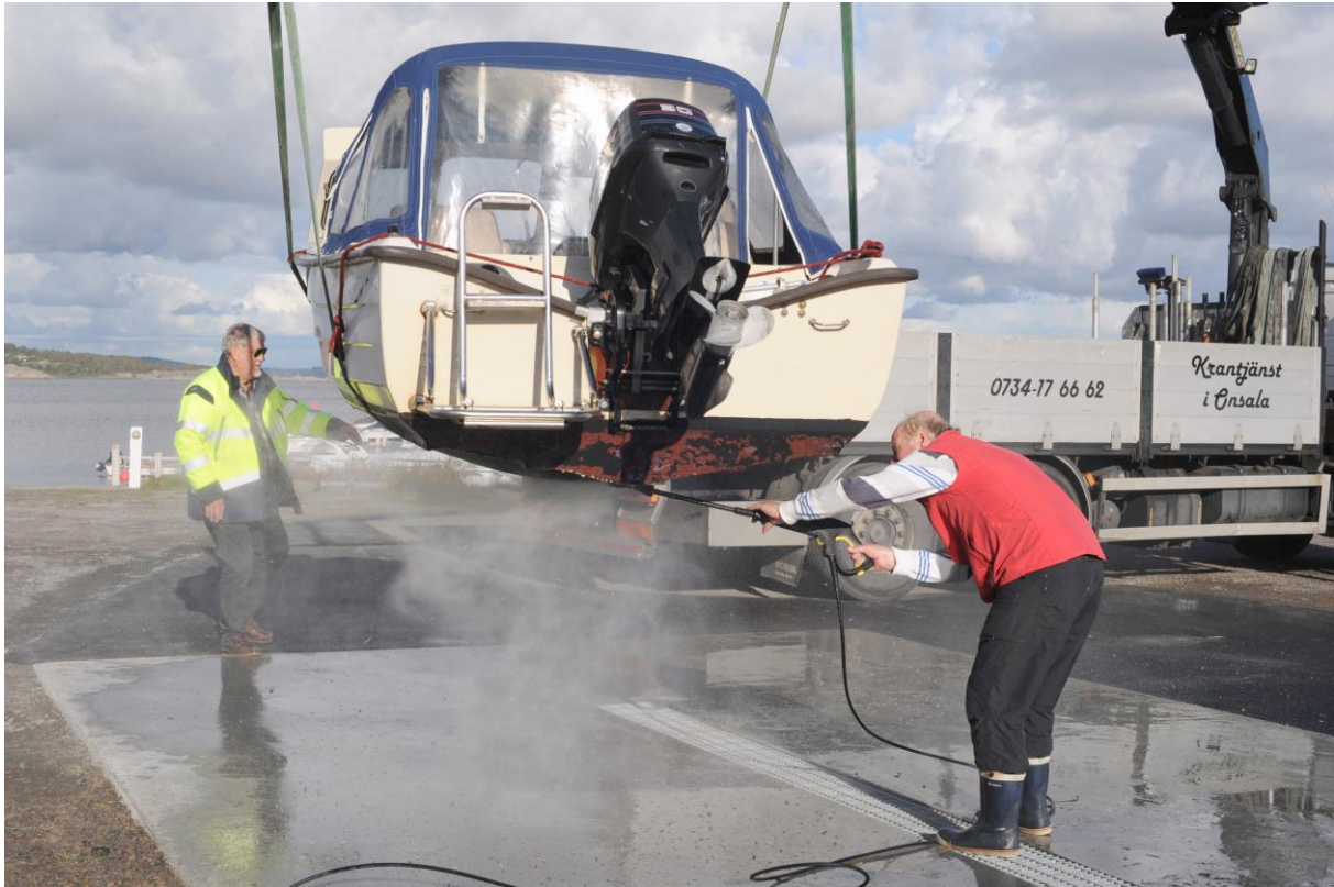
Miljöanpassat båtupptag i Finnasandens hamn, Onsala. Högtryckstvättning över spolplatta med grovrensränna samt efterföljande reningssteg Bild: Lennart Benson
