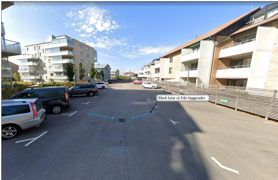
Figur 17. Befintlig dagvattenhantering inom parkeringsplatsen. Bildkälla: Google
