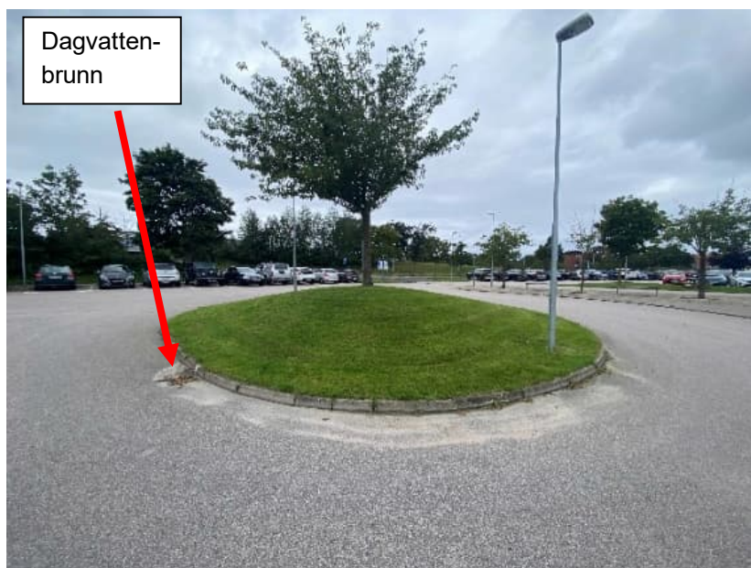
Figur 9. Lågpunkt vid vändplan i söder. Vid lågpunkten finns en gallerbrunn.
