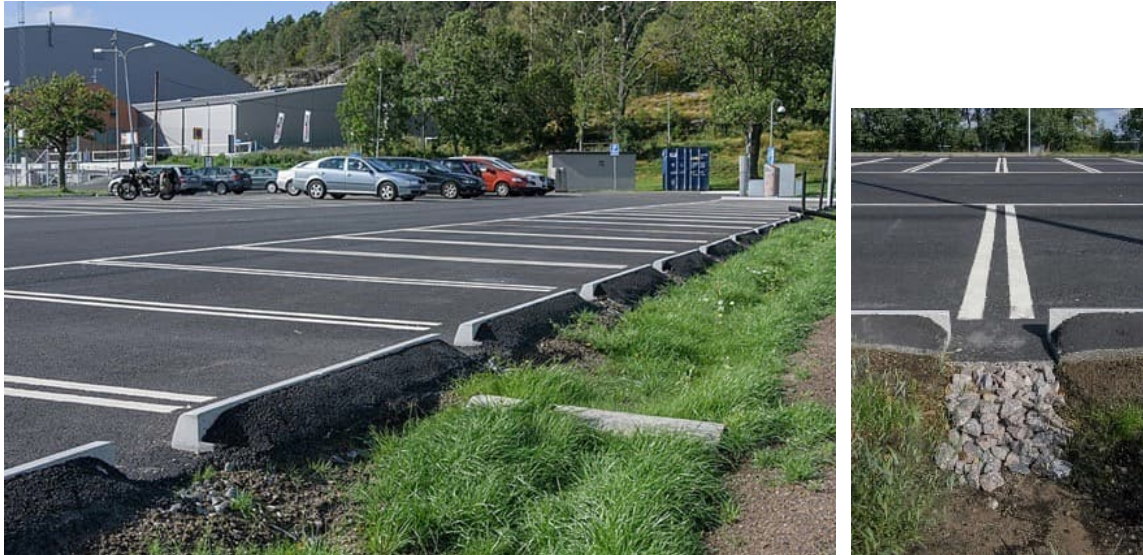
Figur 18. Exempel på översilningsyta från parkering i Kviberg, Göteborg. Bildkälla: SMHI.se (Peter Svensson)
