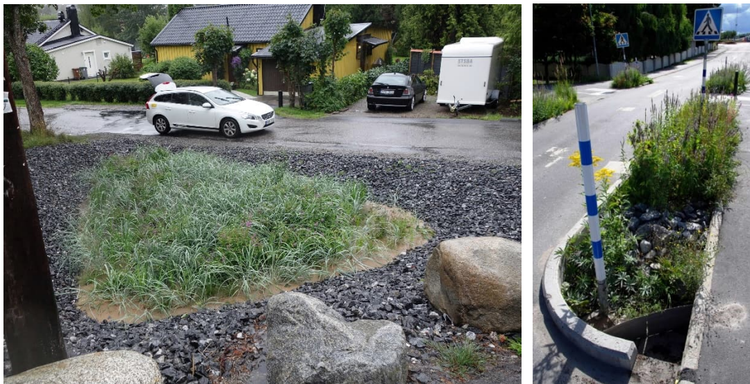
Figur 21. Exempel på nedsänkta växtbäddar. Bildkällor: VegTech AB samt Dagvattenguiden.se
