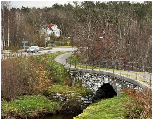
Bild. Gång- och cykelväg över Löftaån.
