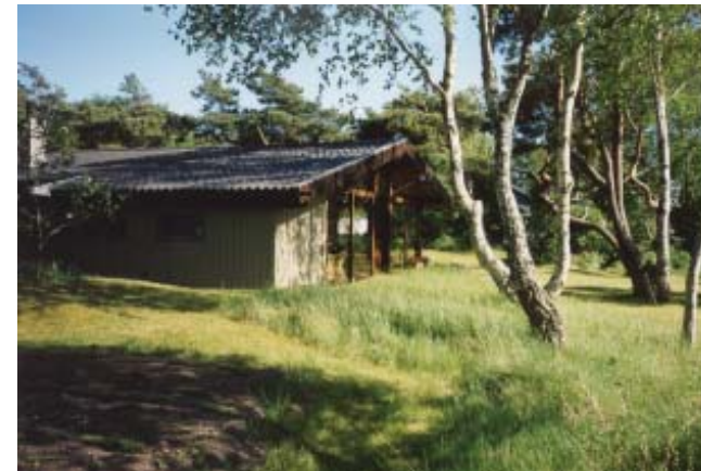
Huset skall placeras så att sprängning, schaktning och utfyllnader kan undvikas och så att naturen kan komma nära huset.
