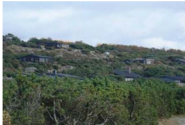
Huset skall placeras så att det underordnar sig landskapet och färgskalan skall vara anpassad efter naturen och omgivande bebyggelse.
