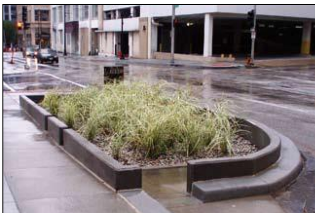
Figur 5. Exempel på regnrabbatt längs en väg, observera utformning av kantsten (Källa: VegTech)
