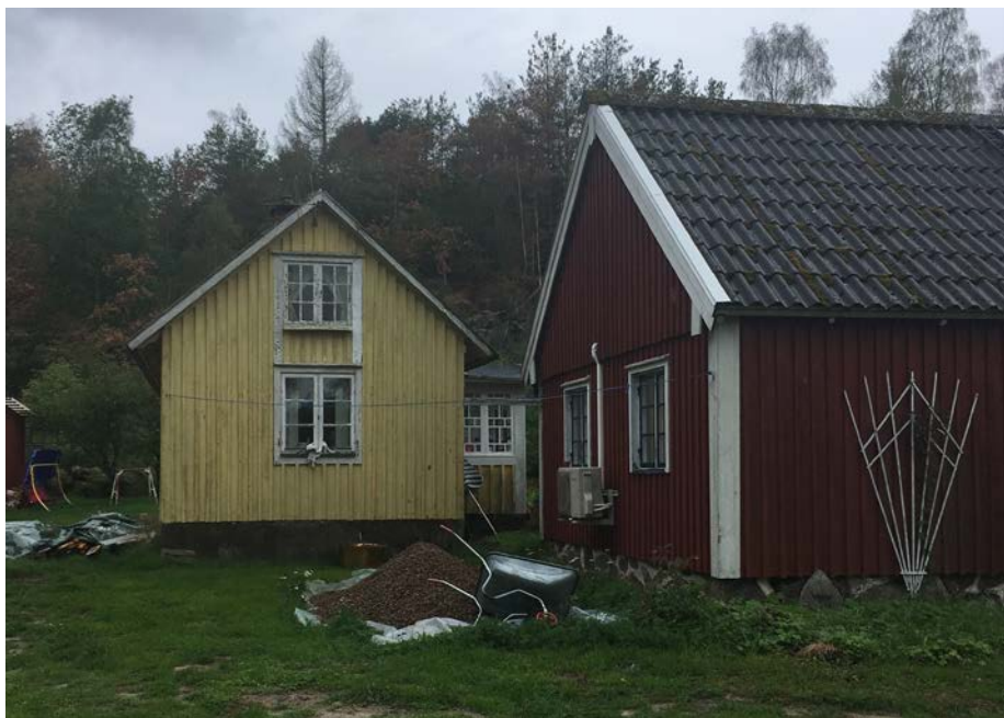
Gul byggnad inom Trönningenäs 1:21 är i Hallandsinventeringen utpekad som klass C.
