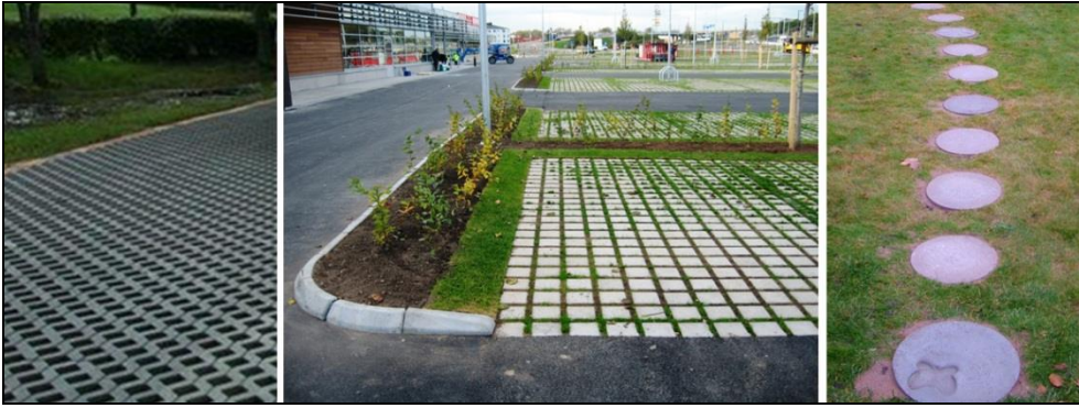
Figur 9. Ytor med hålsten av betong samt gångstig med gräs och gångplattor (Foto: Norconsult)
