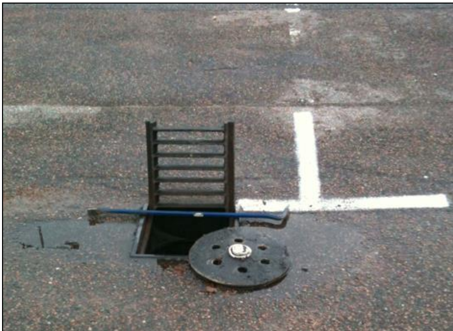
Figur 16. Filterplatta som placeras i rännstensbrunn (Foto: acitex.se)
