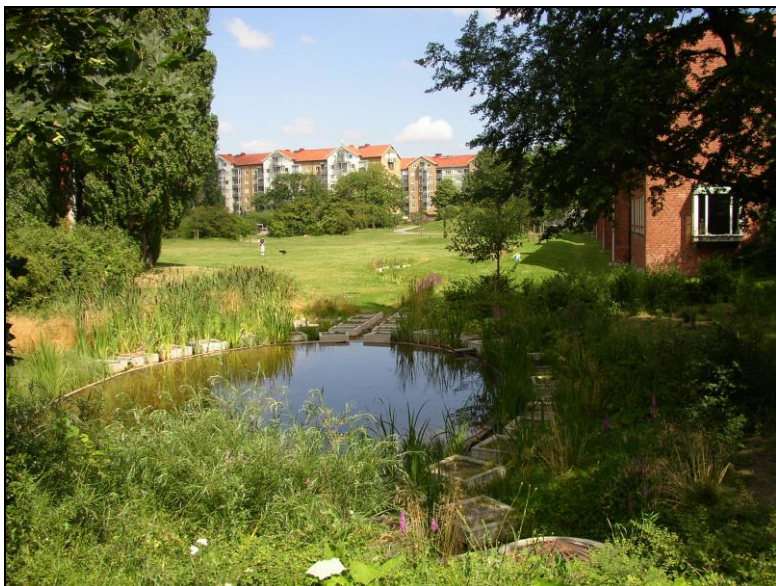
Figur 14. Fördröjningsdamm (Foto: Norconsult)
