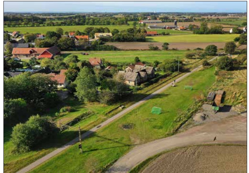
Ovan: Ingelstråde gamla stationshus i Höganäs kommun där ett parti av det nedlagda spåret, perrongkant och kontaktledningar bevarats jämte den anlagda gång- och cykelvägen, vilket skapar en tydlig järnvägskontext.
