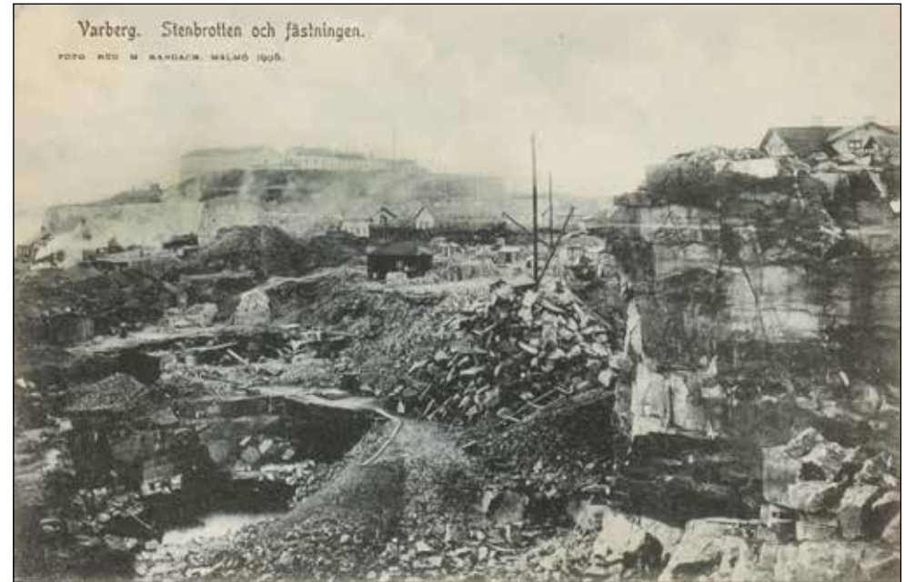
Fästningsbrottet år 1906 – ett landskap i fullständig förändring. Bilden ger en uppfattning om vilken påverkan stenhuggerierna fick på landskapet kring Varberg.
