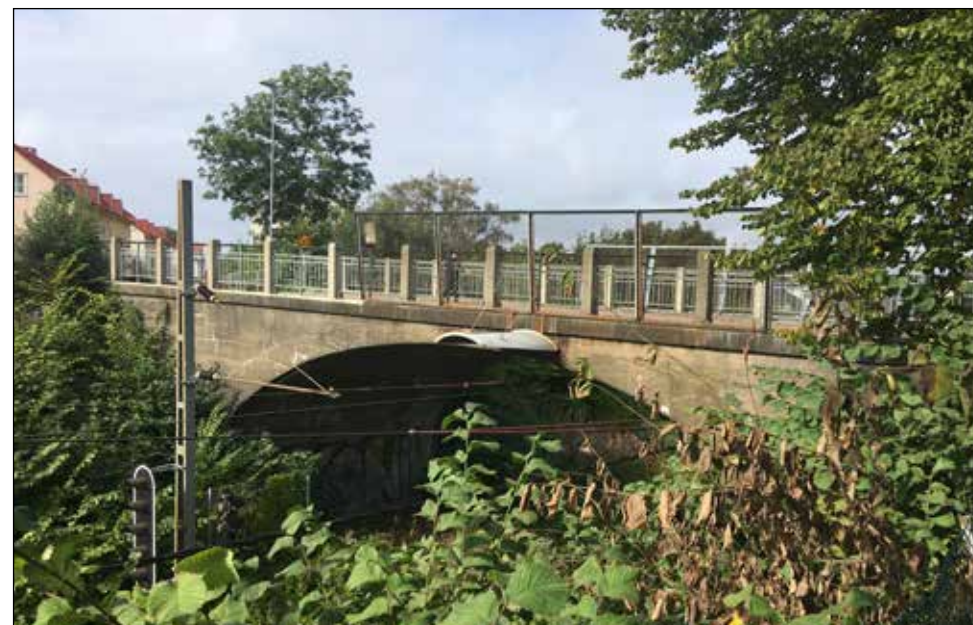
Ovan: En av betongbroarna från 1920-talet. Den krysshamrade betongytan är stenimiterande vilket ger intrycket av ett mer påkostat yttre. Nedan vänster: Karta med redovisade kulturhistoriska kvaliteter i nära anslutning till befintlig järnvägssträckning. Nedan höger: Närbild på stenmur och stenbelagd ravinsida intill banvallen.
