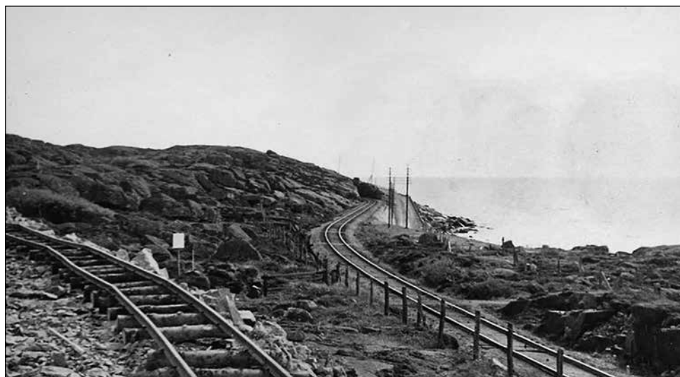
Flera generationer järnväg strax norr om Hästhagabergen. Till vänster syns 1930-talets nya sträckning, med en provisorisk räls utlagd. Till höger stråket som togs i bruk 1920, när banvallen i skärningen förbi Platsarna drogs ned till 1880-talets skärning intill havet.
