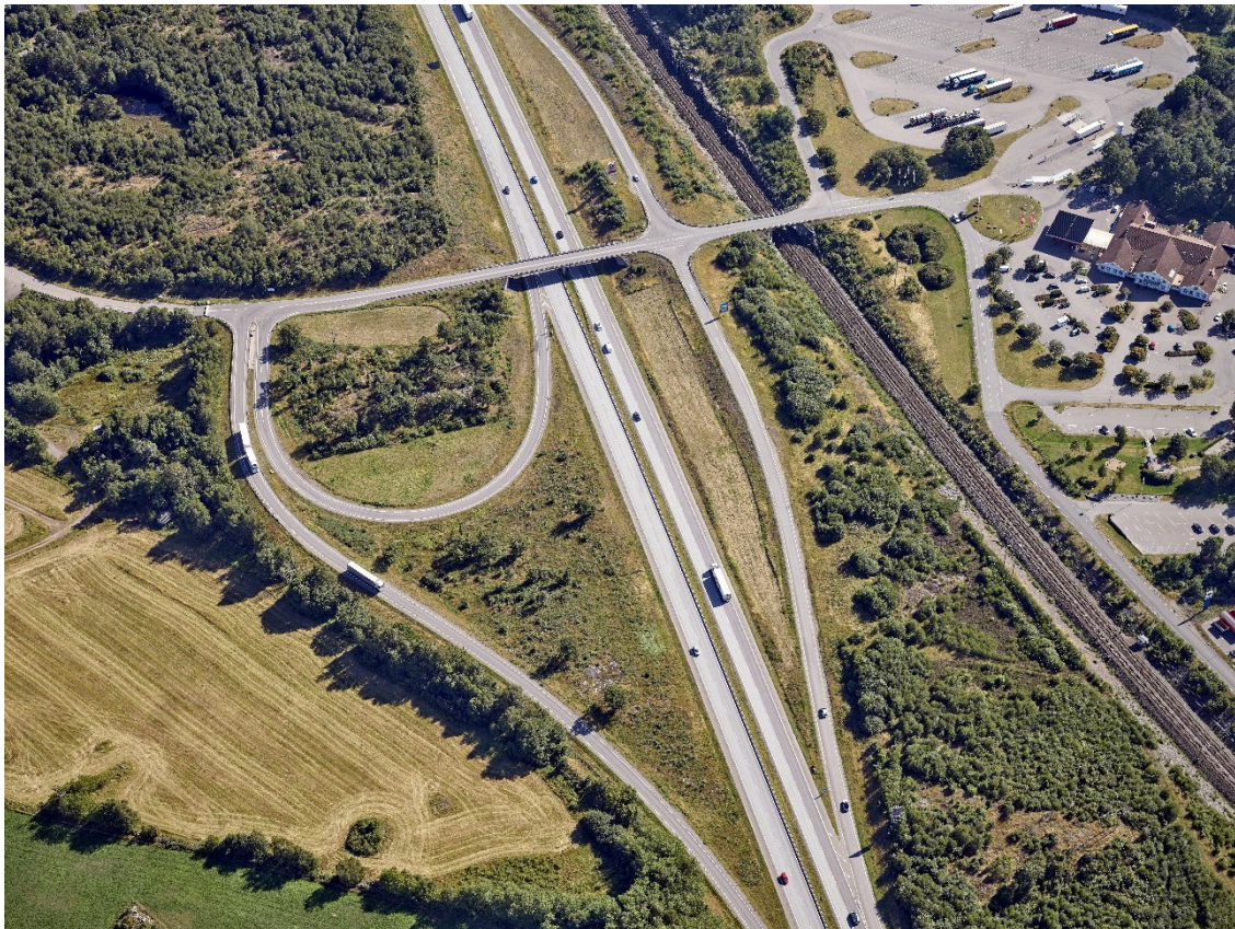
Bild 29. Foto från programområdets år 2022. På bilden syns den befintliga motorvägsavfarten och rastplatsen med restaurang och lastbilsparkering till höger i bild. ©Varbergs kommun
