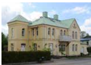
Det före detta stationshuset är en märkesbyggnad i centrala Tvååker.
