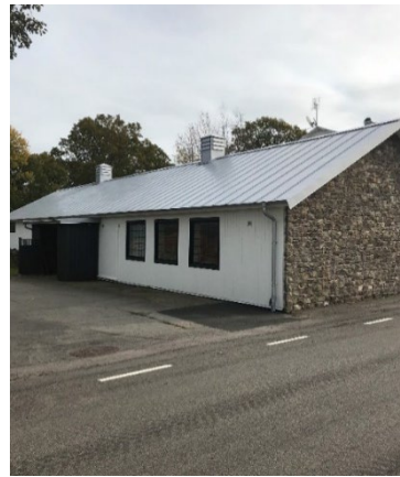
Byggnad i en våning.
