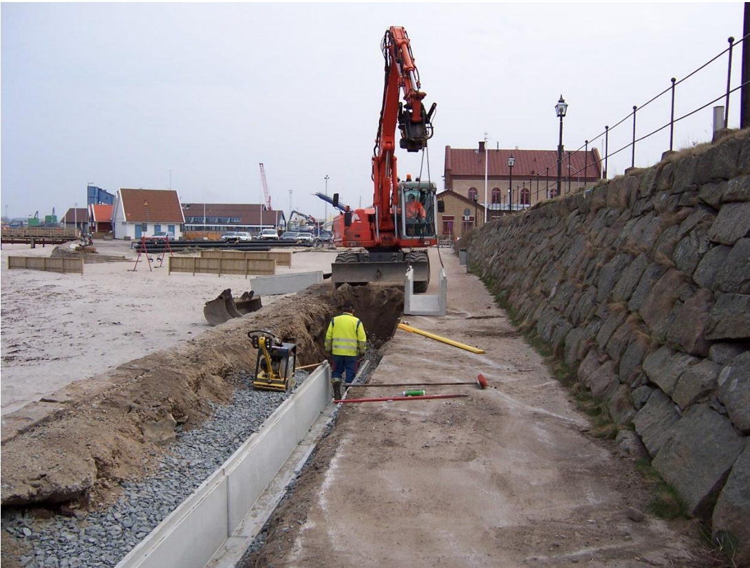
Foto 5 Fjärrvärmekulverten byggs
