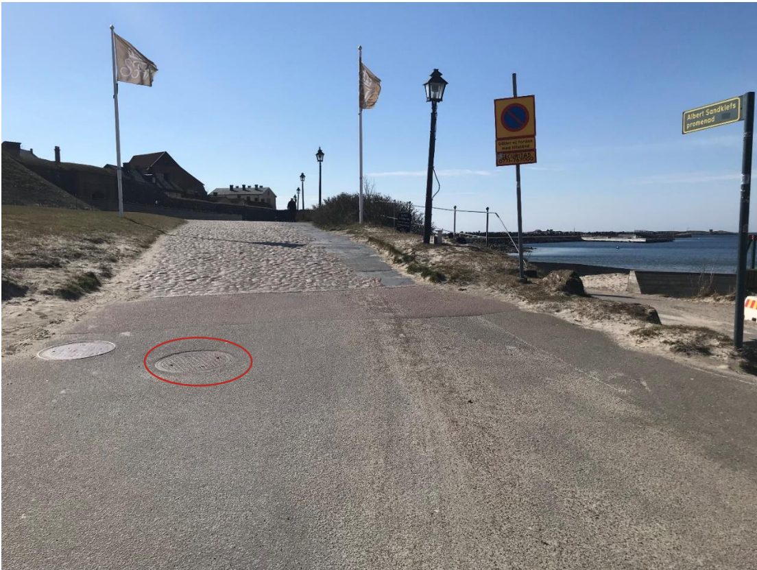
Foto 1 Brunn dit tryckspiledning ansluts
