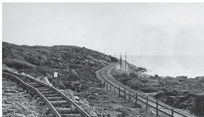
Flera generationer av järnväg, strax norr om Hästhagabergen. Bild ur Kulturmiljöutredningen.
